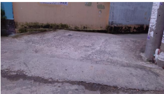
Khu 2 (gờ chắn nước mưa đầu hẻm)
