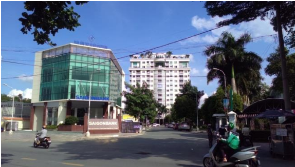
Khu 1 (vị trí hồ ga tiêu thoát nước)
